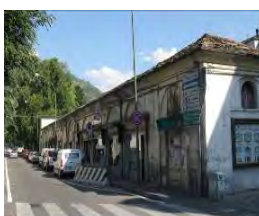
I FABBRICATI DELLA CASERMA ESISTENTE
