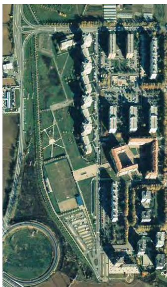
FOTO AEREA DELL'INTERVENTO
